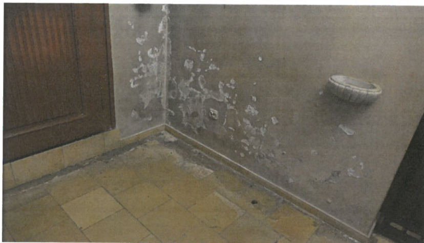
Zdj. 3. Destrukcje tynku ściany północnej (fot. C Magott)
