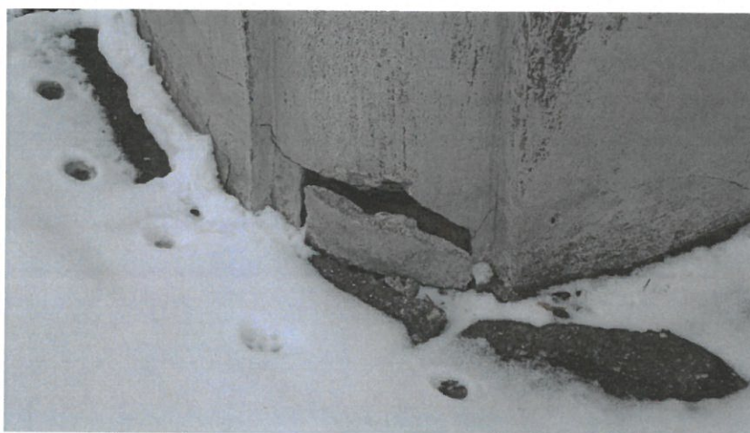
Zdj. 10. Ubytki tynku na cokole – ściana wschodnia (fot. C Magott)
