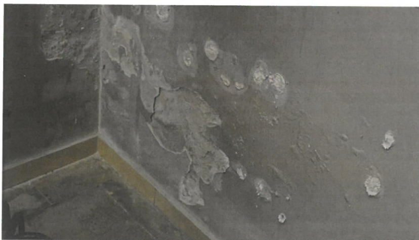
Zdj. 5. Lisco tynku w narożniku ściany północnej i wschodniej (fot. C Magott)
