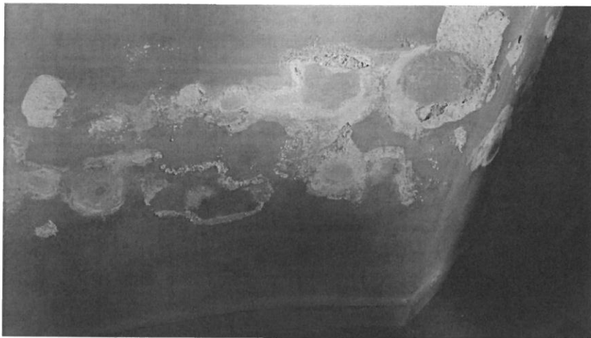
Zdj.6. Destrukcje soli budowlanych – ściana wschodnia (fot. C Magott)
