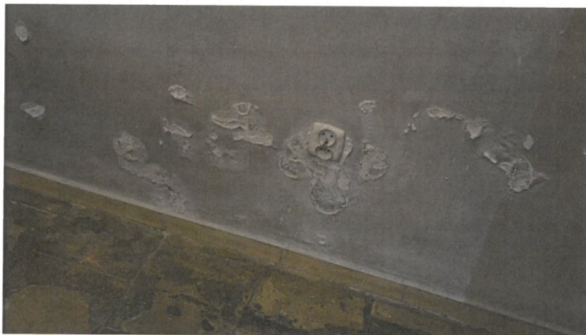
Zdj. 4. Widoczne zasolenie fragmentu ściany zachodniej (fot. C Magott)
